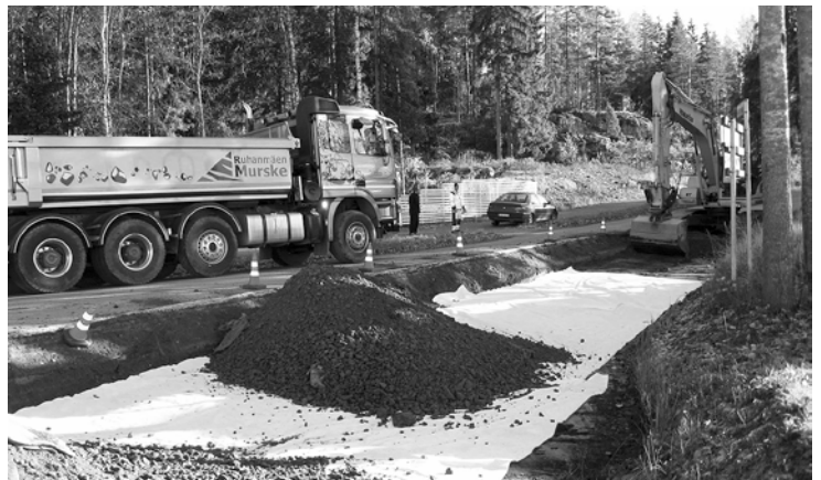
Maanantaina 14.10.2013 alkoi Kukonojantien päällystystyö Oivonojalta. Kylän miehet työn ääressä.
