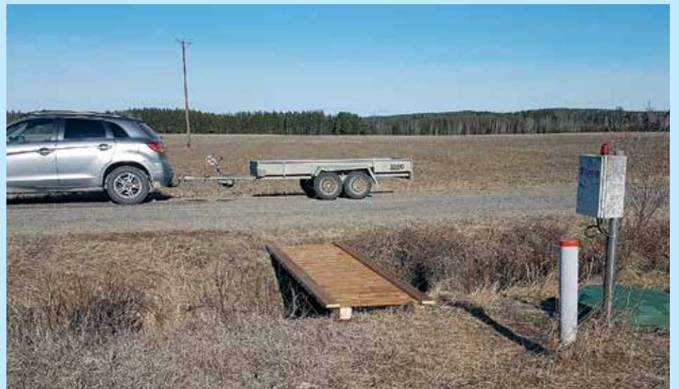
Kävelysilta jätevesiverkoston linjapumppaamon 17 viemärin yli.
