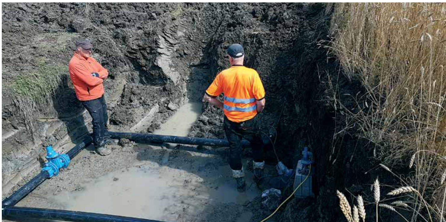
Linjaventtiilin asennusta Hongistossa
